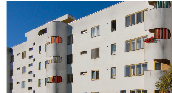
Großsiedlung Siemensstadt Walter Gropius 1929
