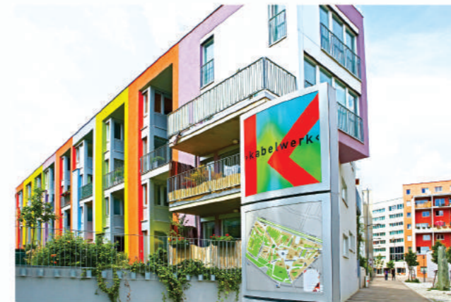
Kabelwerk Source by: Stadt Wein
